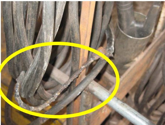
Foto 9 – Cabos da máquina de solda
