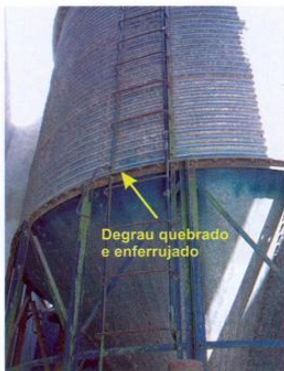
Figura 2: Escada tipo marinheiro, para acesso ao topo do silo existente na área externa do armazém
