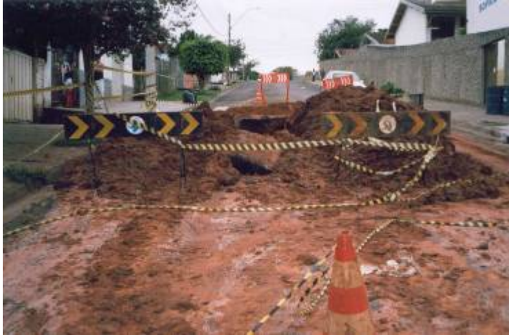
FOTO 2 – POSIÇÃO DA VALA
