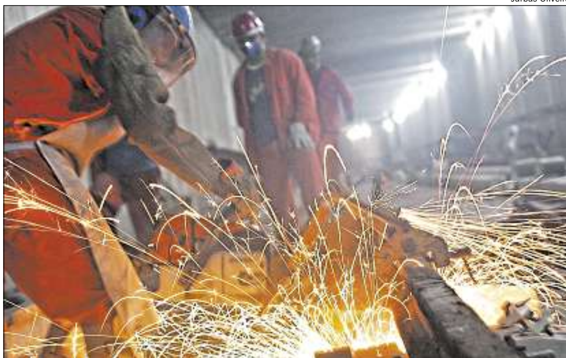
OPERÁRIOS TRABALHAM nas obras subterrâneas do metrô de Fortaleza: duas mortes no projeto em 2010
