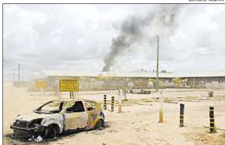
INSTALAÇÕES DA usina de Jirau destruídas após rebelião dos trabalhadores
